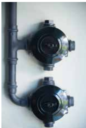
Μονός διακόπτης berker 1930, με κουτί επίτοιχης τοποθέτησης και εξωτερική εγκατάσταση.
